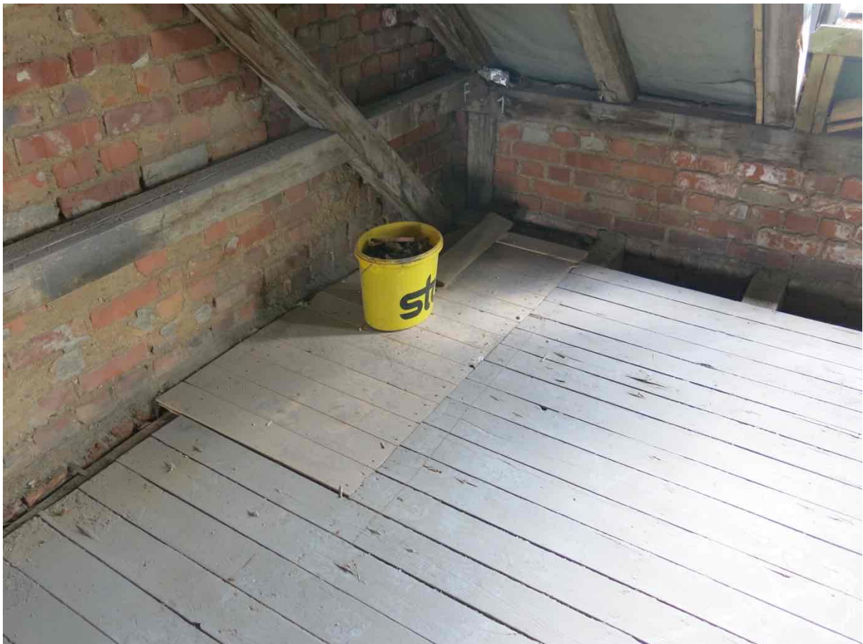
Dachgeschoss Holzbalkendecke, Achsen 1 – 2/ F
