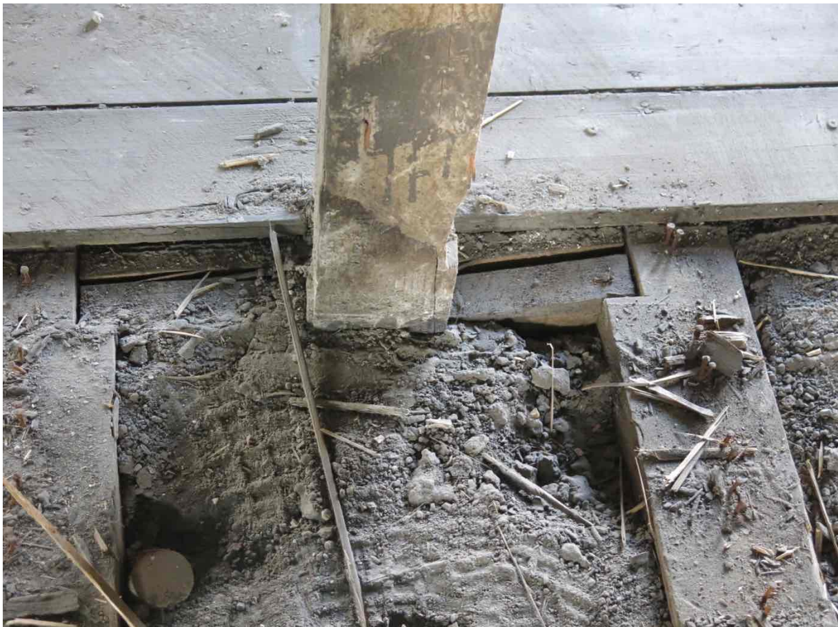
Dachgeschoss Pfettenständer auf einem Wechsel, Achsen 19 – 20/ B
