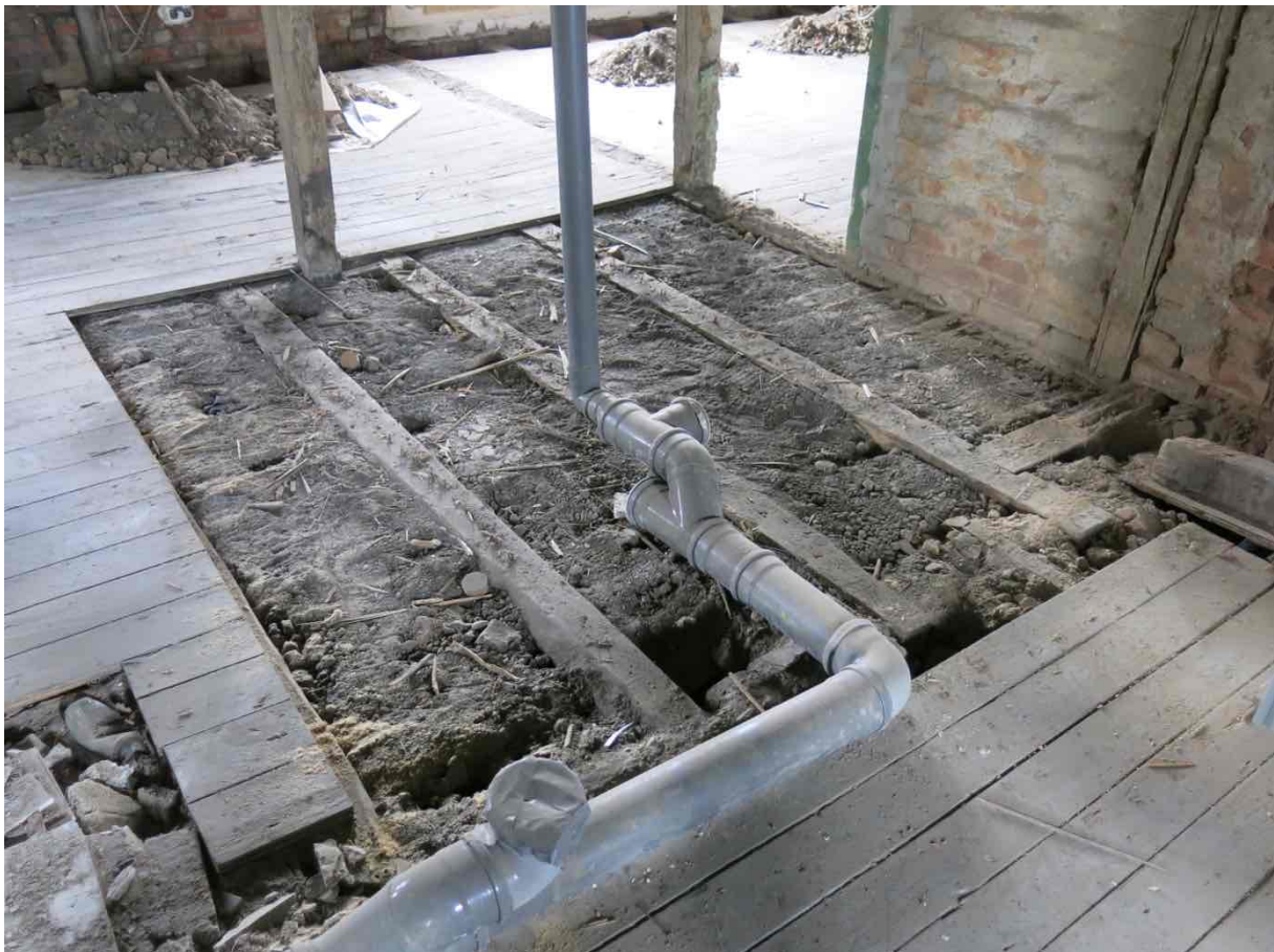
Dachgeschoss Holzbalkendecke, Achsen 17 - 21/ B - C
