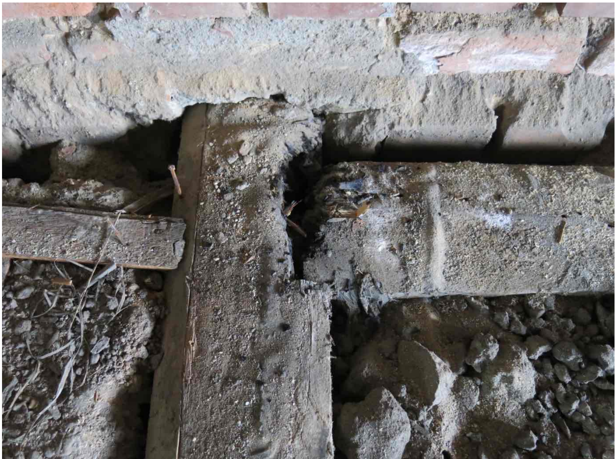
Dachgeschoss Holzbalkendecke, Achsen 29 - 30/ C
