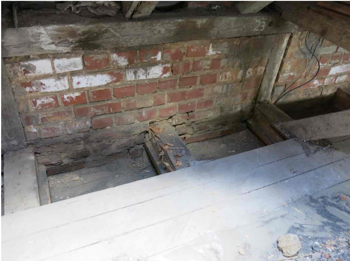
Dachgeschoss Holzbalkendecke, Achse 22/ F
