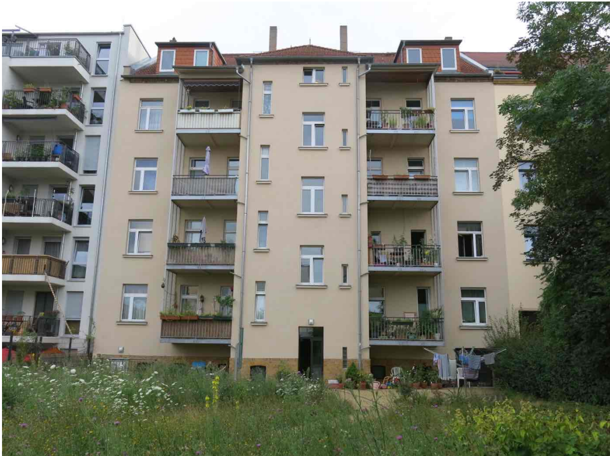
Ansicht des Hauses Arno- Nitzsche- Straße 8, im Hof Südseite.
