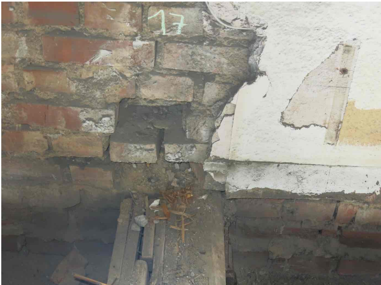
Dachgeschoss Holzbalkendecke, Achse 17/ A
