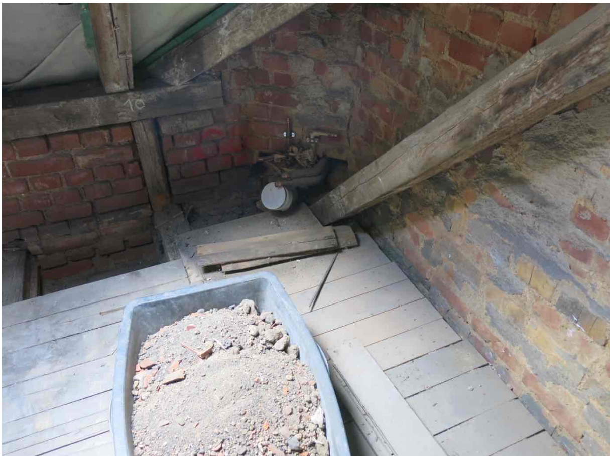
Dachgeschoss Holzbalkendecke, Achsen 10 – 11/ F
