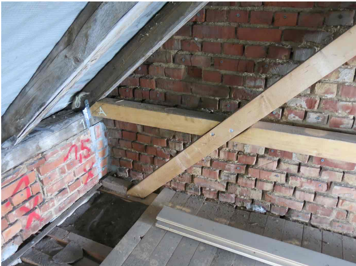
Dachgeschoss Drempel- und Giebelmauerwerk, Achsen 1 – 2/ A - B
