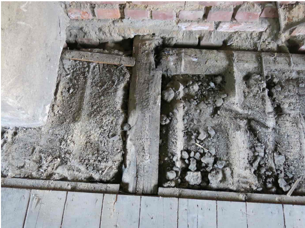
Dachgeschoss Holzbalkendecke, Achsen 29 - 30/ C
