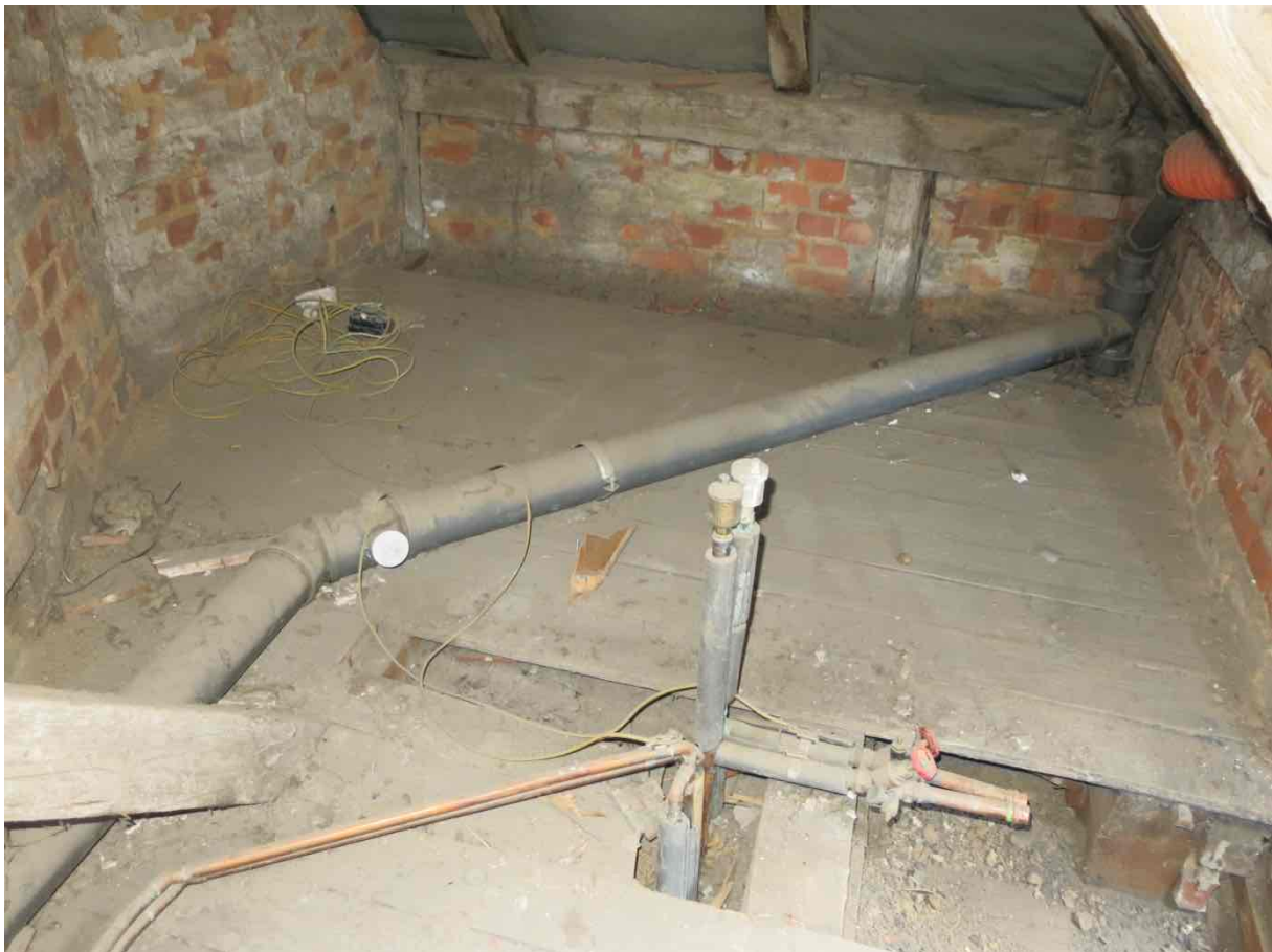
Dachgeschoss Holzbalkendecke, Achsen 18 - 21/ F - G
