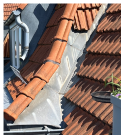
Foto Zwickel Giebelmansarden:
