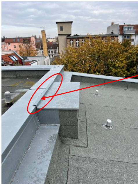
Bild 19, das Dach ist bis auf einige Blechanschlüsse am abgedeckten Schornstein unauffällig, die Gebäudefuge zwischen dem untersuchten und dem rückseits angrenzenden Gebäude ist dicht
