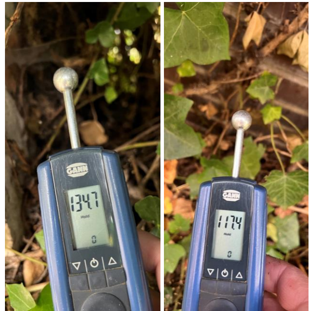
Bild 16, messtechnisch feucht-nass; teilweise ohne Putz (dahinter befindet sich das Bad)
