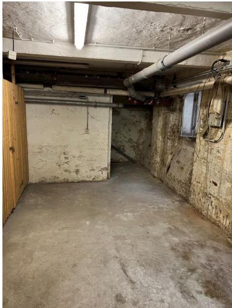
Bild 9, Keller unter dem Gebäude, die Wohnung selbst ist nicht erkennbar unterkellert (Keller endet vor der Wohnung)
