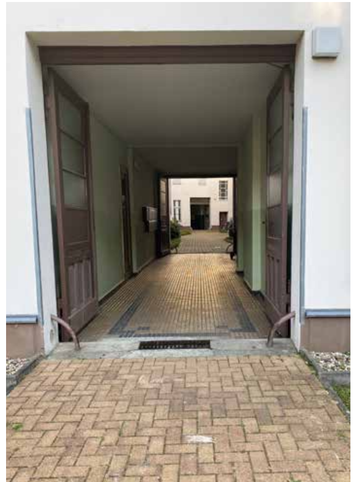
Foto Durchfahrt Hinterhaus
