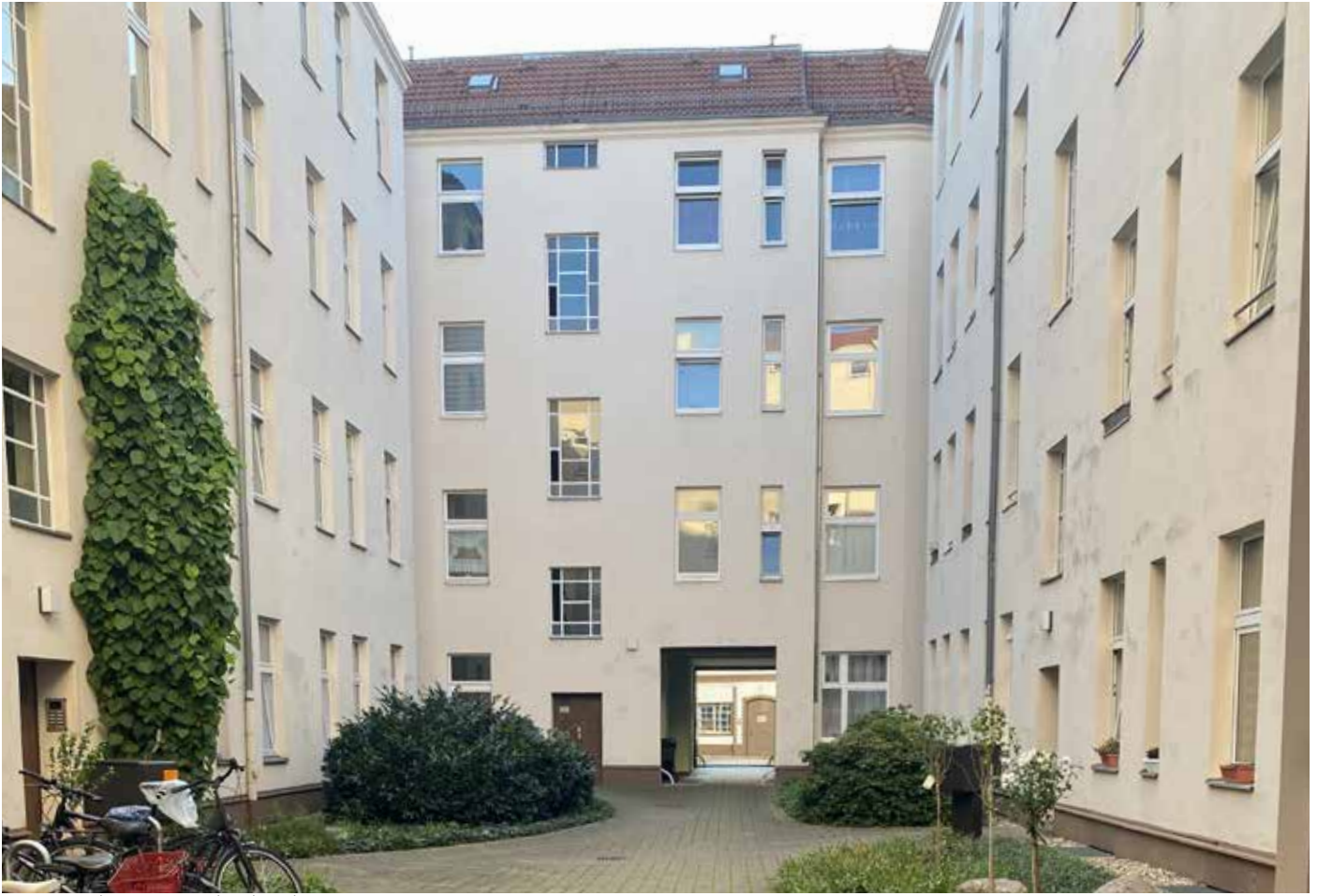
Foto 1. Hinterhof, Blick in Richtung 2. Hofdurchfahrt
