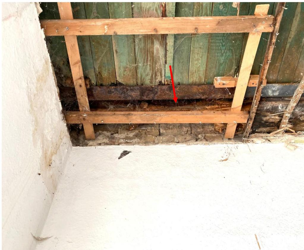
Foto 5: Balken in Achse 5 – Befall am Balken, Korrosion Stahlträger
