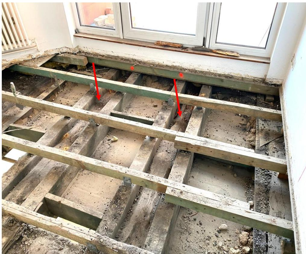
Foto 3: Detail Foto 2 – Achse 2-5 – Schäden in Achse 3 + 4
