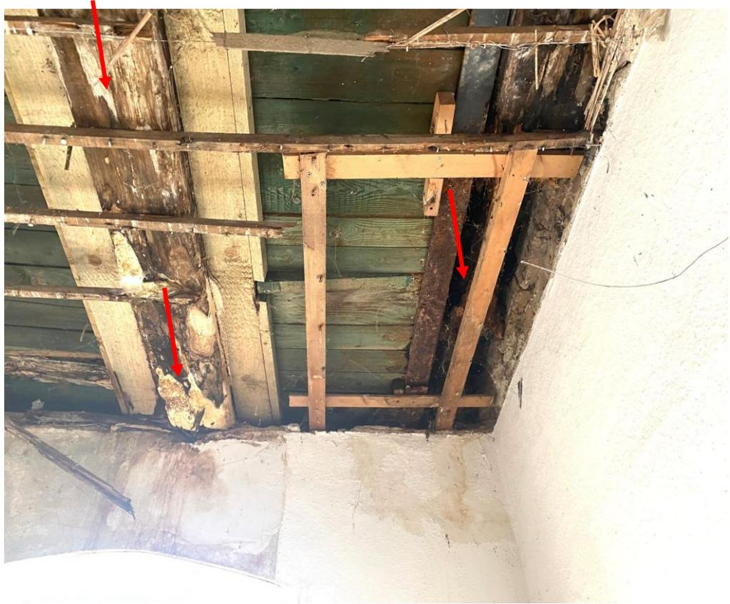
Foto 6: OT 2024-09-19 – Unterseite Balken Achse 4 +5 (Befall)
